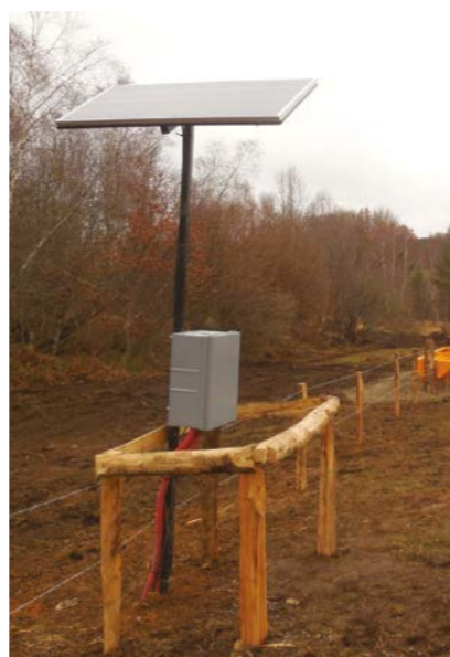
Installation d'un abreuvoir solaire ! Une première pour l'équipe travaux en Corrèze.
